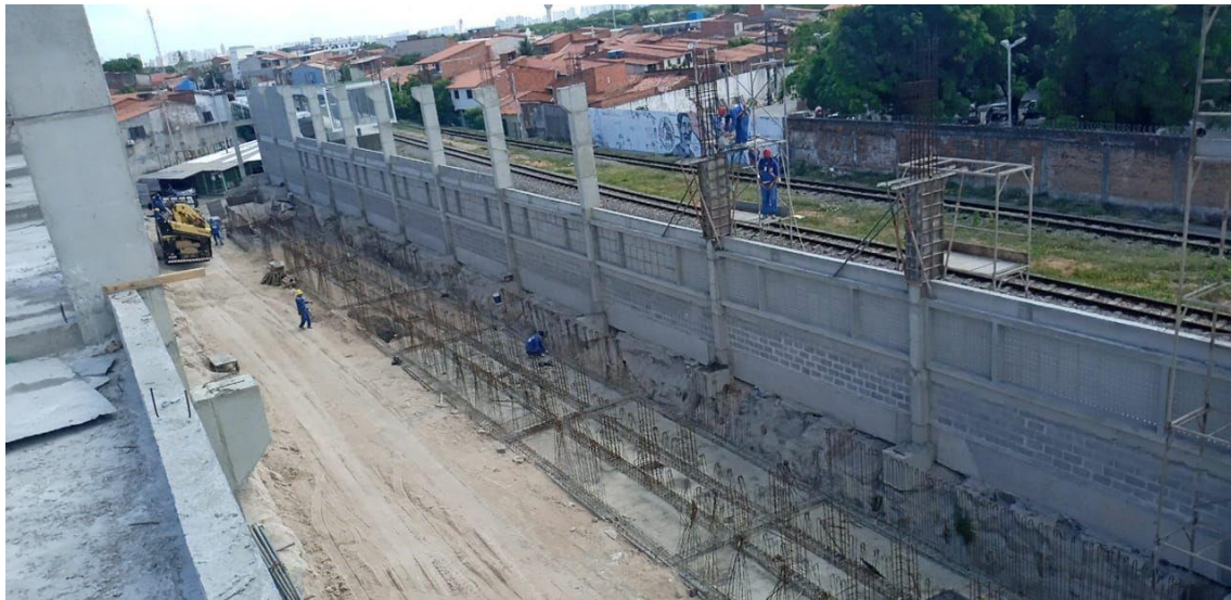
Figura 1 – Obras do Centro de Manutenção do VLT Parangaba-Mucuripe
