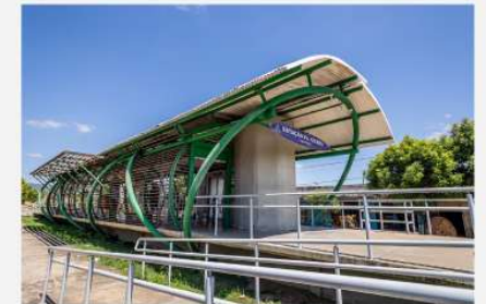
Imagem 21: Estação Padre Cícero, VLT Cariri METROFOR
