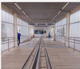
Imagem 08: Estação Iate, Linha Nordeste METROFOR
