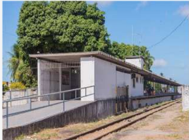
Imagem 09: Estação Iate, Linha Nordeste METROFOR
