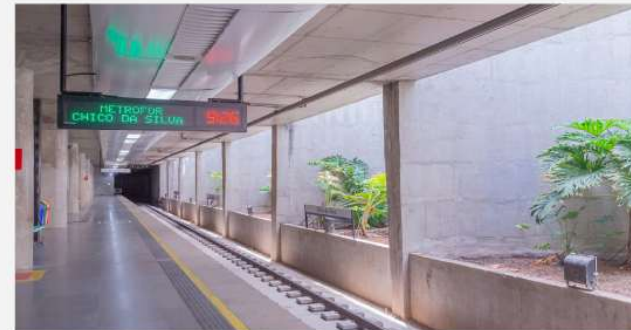
Imagem 49: Jardim interno Estação Chico da Silva, Linha Sul METROFOR
