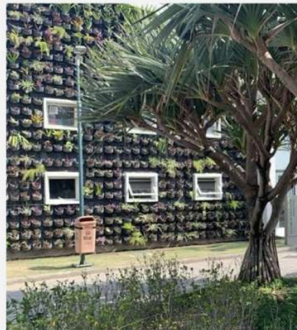
Imagem 50: Fachada verde instalações Parque Madureira, Rio de Janeiro (RJ)
